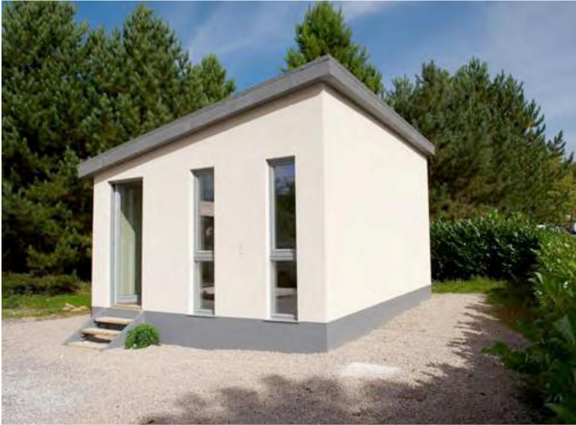
Figura 1: edificio sperimentale in canapa-calce (HemPod) dell'Università di Bath
