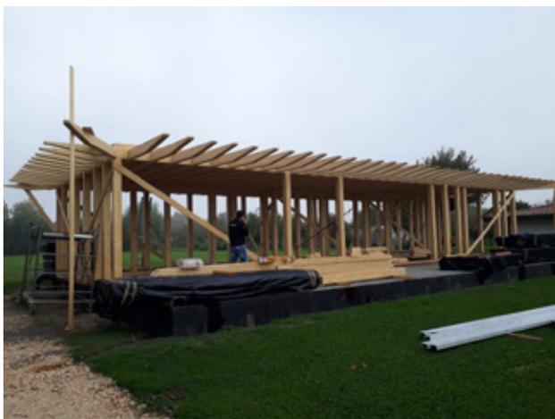
La struttura in legno viene tagliata e preparata in stabilimento come nei sistemi prefabbricati per i quali si affronta il perfezionamento del progetto prima di iniziare il cantiere. Questo permette di ridurre i tempi di realizzazione ed eliminare gli extra costi di cantiere per il committente.
