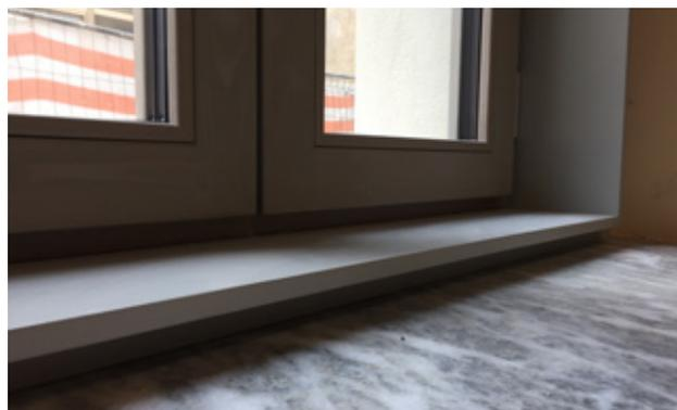
L'intervento ha previsto la sostituzione dei **serramenti** esistenti con serramenti in legno, la realizzazione di un **cappotto** esterno per la porzione storica del fabbricato (struttura in legno e riempimento in calce canapa) e l'**isolamento** mediante insufflaggio di canapulo per la porzione a cassa vuota.
