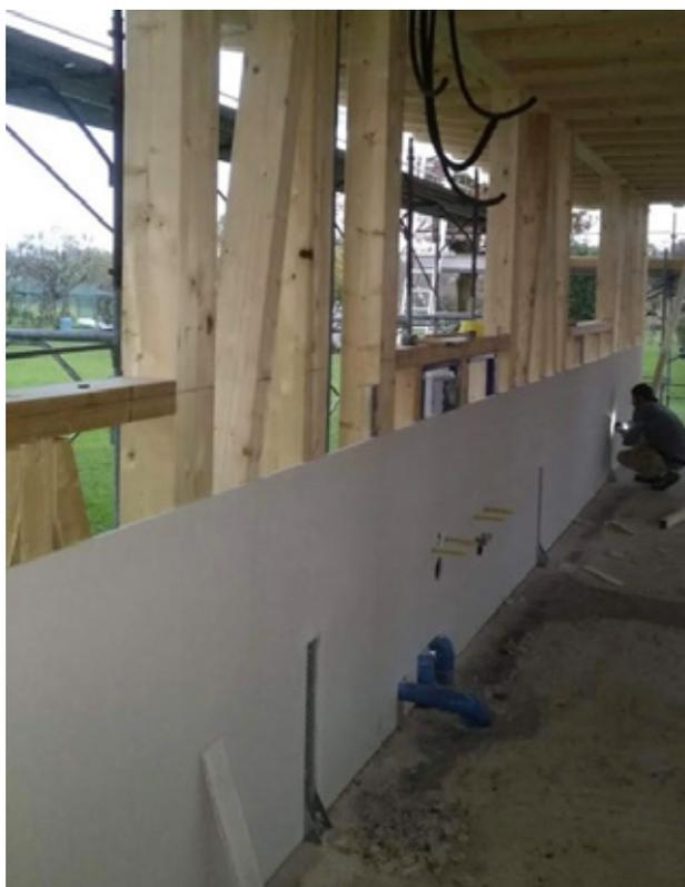
A questo punto è possibile iniziare con la realizzazione delle pareti perimetrali. Uno dei nostri sistemi di temponatura prevede il montaggio di una pannellatura interna in gessofibra che successivamente fungerà da cassero sul quale applicheremo **Natural Beton® 200** di canapa e calce.
