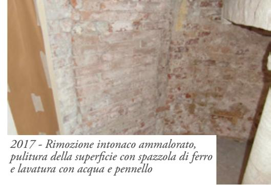
2017 - Rimozione intonaco ammalorato, pulitura della superficie con spazzola di ferro e lavatura con acqua e pennello
